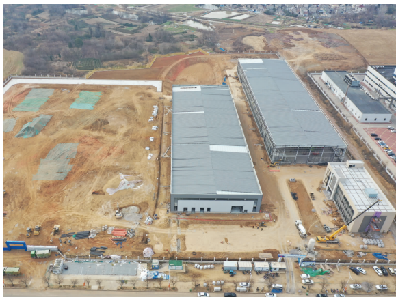
■江苏省重大项目凯米膜施工现场
