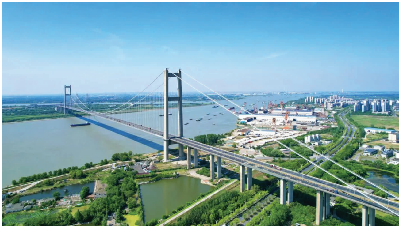
■润扬大桥 黄 帅 / 摄
