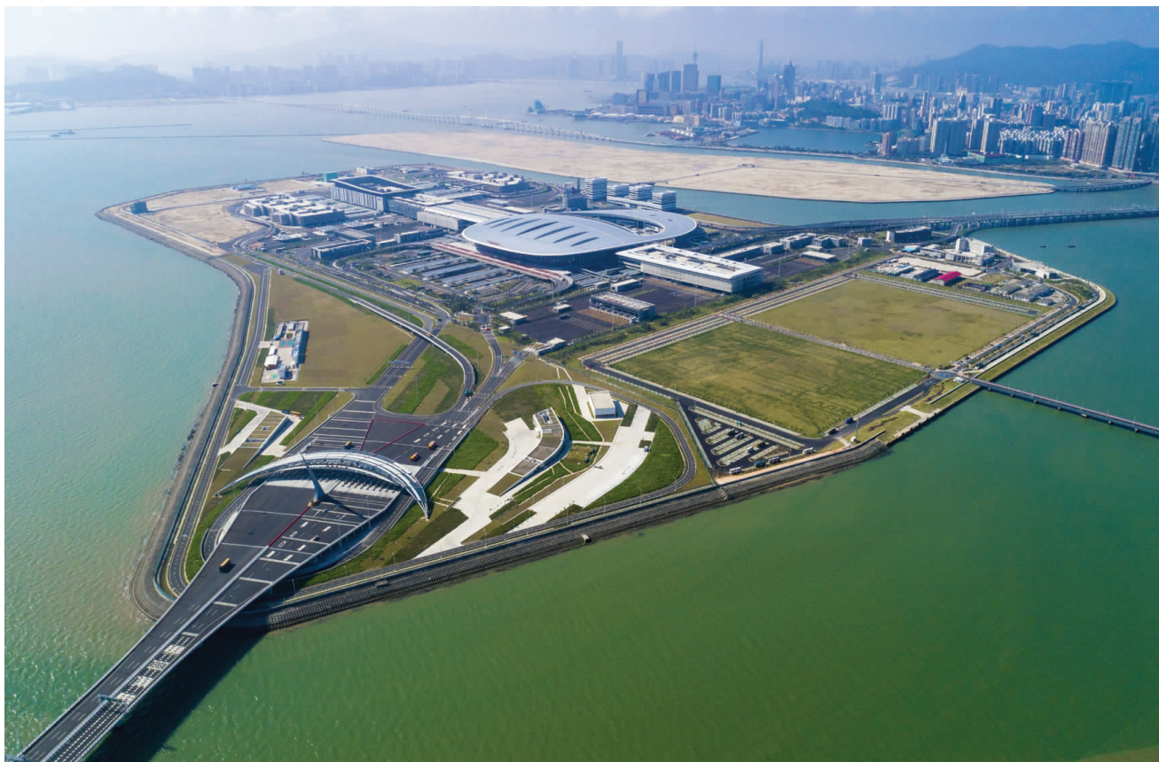
■南通四建集团有限公司承建的港珠澳大桥人工岛
