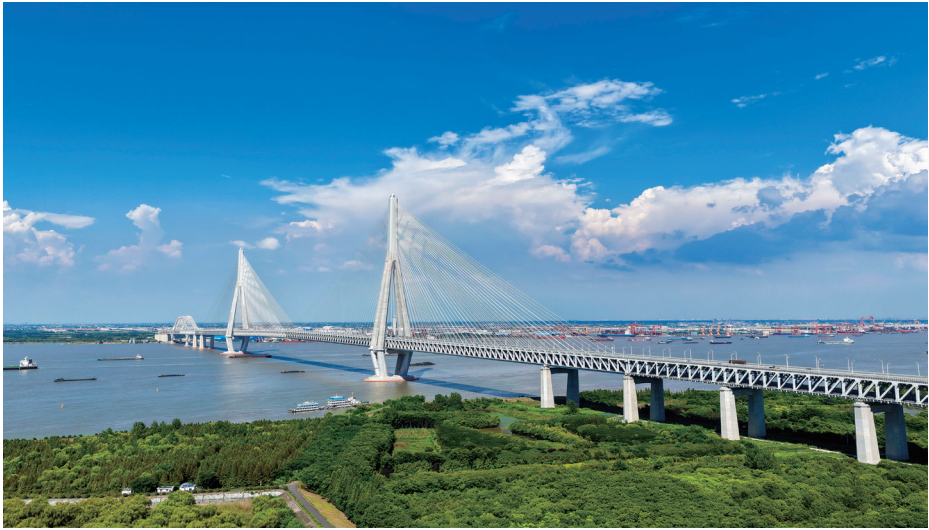
▲ 常泰长江大桥飞架大江两岸，桥下江岸绿意绵延。
