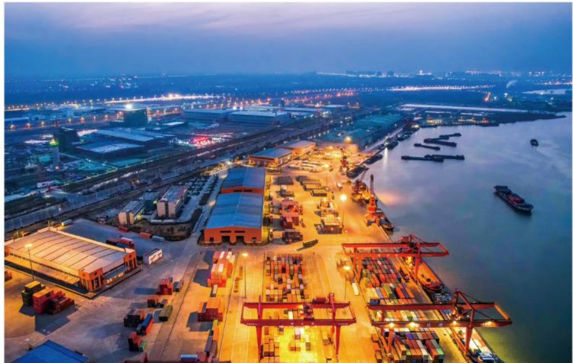
▲宿遷市宿城區運河宿遷港燈火通明，機械設備正在裝卸集裝箱，一派繁忙的作業景象。 陳少帥 攝
