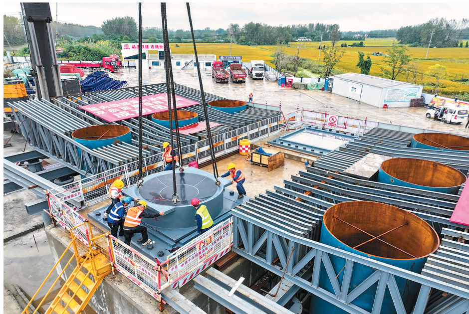
10月14日，在宁扬城际（扬州段）跨仪扬河矮塔斜拉桥施工现场，随着600吨汽车吊的巨臂缓缓升起，单个净重143吨的“钢铁巨无霸”——国内铁路最大承载力双曲面摩擦摆支座成功吊装就位，标志着跨仪扬河矮塔斜拉桥即将进入上部结构主梁的施工。作为中国首条跨越长江的城际地铁线路，建成后，将大幅缩短南京与扬州的时空距离。 陈俨/摄
