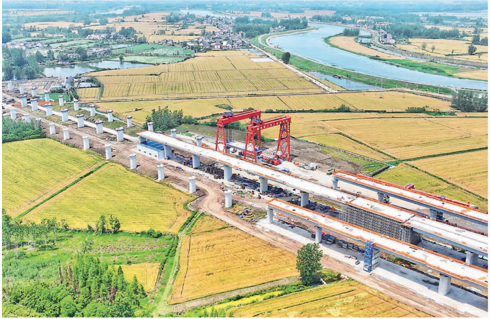
▲ 5 月 17 日，一孔長 32.6 米、重 458 噸的箱梁平穩精準地架設在橋墩上，標志着由中鐵上海工程局承建的寧淮城際鐵路順利完成首孔箱梁架設，全綫進入橋梁施工加速階段。作為江蘇沿江城市群幹綫與長三角城際軌道網重要組成部分，該城際鐵路新建綫路全長 179 公裏，設計時速 350 公裏。建成後，南京與淮安將實現 1 小時直達。
