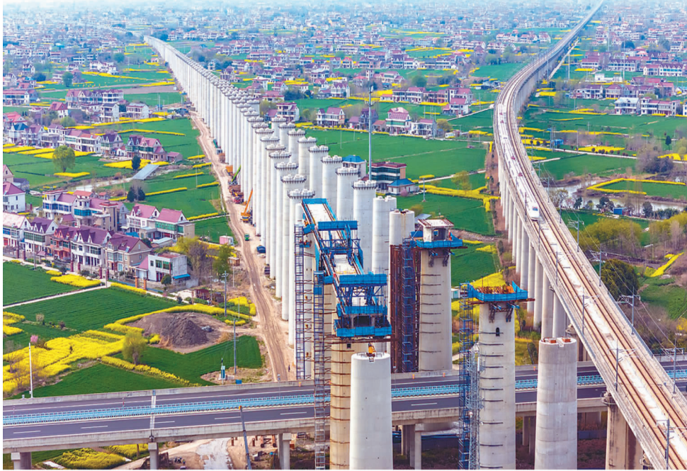
▲日前，北沿江高鐵建設正穩步推進。作為新建滬渝蓉高鐵的重要組成部分，北沿江高鐵將在上海大都市圈、南京都市圈和合肥都市圈間建起一條快速新通道。圖為3月31日，一輛動車組列車從南通市通州區北沿江高鐵跨過通運河特大桥施工現場旁駛過。
