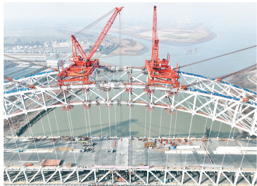
1月12日，随着最后一块面板吊装完成，常泰长江大桥安洲专用航道桥顺利合龙。至此，常泰长江大桥除了主航道桥以外，其余部分均已建成。陈曦摄
