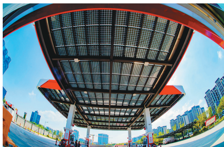
8月23日，渡江综合加能站是扬州首座实现净零排放的“碳中和”加能站，也是中石化江苏石油首座BIPV（光伏建筑一体化）加能站，因为人们正在该加能站给车辆加氢、充电。
