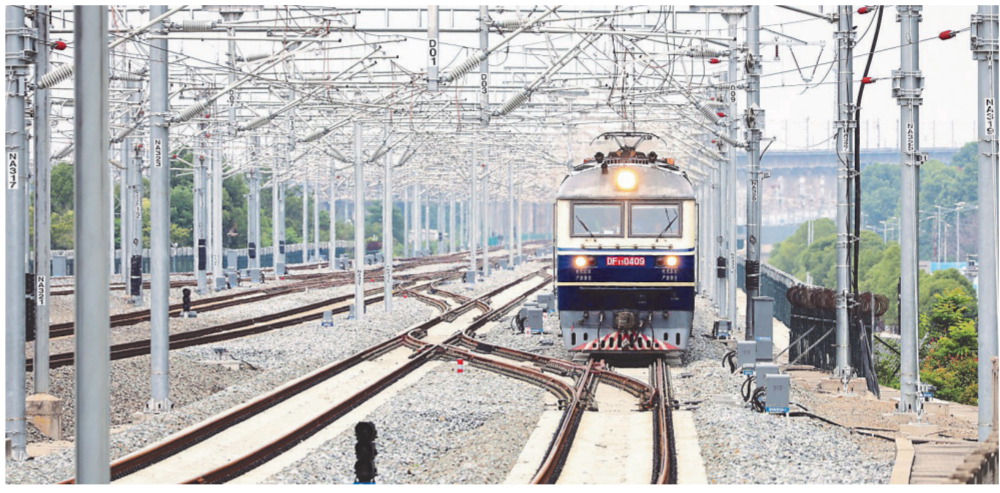
沪宁沿江高铁近日进入联调联试阶段。沪宁沿江高铁线路全长279公里,设计时速350公里。全线共设南京南、太仓等8座车站,其中句容、金坛、武进、江阴站为新建车站。联调联试结束后,将转入运行试验阶段,预计9月份具备开通运营条件。 苏阳摄
