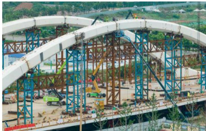
6月3日，南京梅苑南路跨秦淮新河大桥施工现场。近日，该大桥主体结构已经全部吊装完成，施工方中建三局的建设者正在进行箱梁焊接、顶推设备调试和临时支墩的安装。大桥建成通车后，将进一步改善区域交通环境，为当地民众出行提供便利。（无人机照片） 泱波 摄
