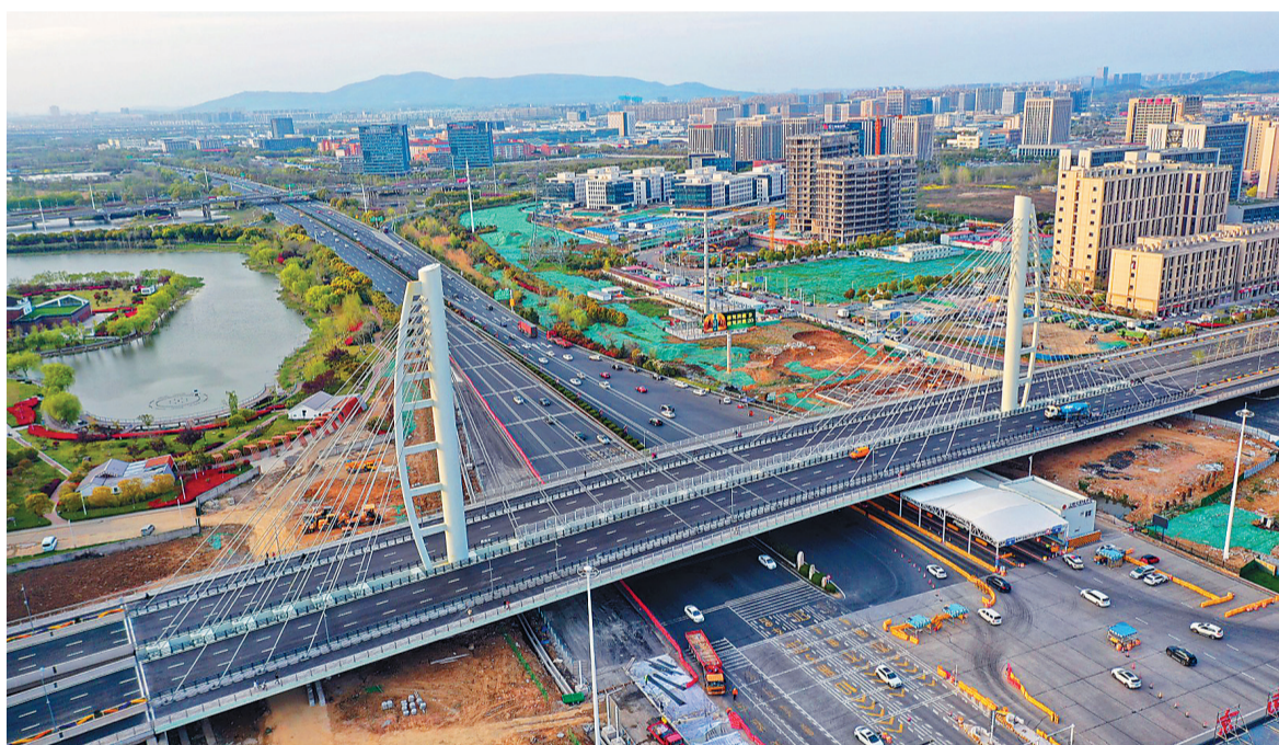
南京市江宁区「三重一大」项目文靖路高架桥四月三日晨通车。 赵亚玲摄
