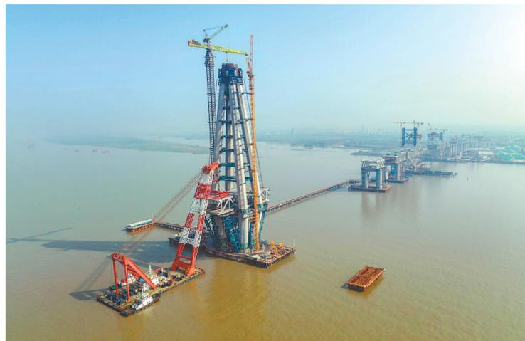
11日，随着一片重达1642吨的大节段钢桁梁平稳吊至支架上，中交二航局常泰长江大桥5号墩墩顶最后一节段钢桁梁成功吊装，标志着大桥主航道桥墩顶梁架吊装全部完成，常泰长江大桥建设再提速。图为5号主墩墩顶最后一节段钢桁梁架设现场。赵振宇 摄
