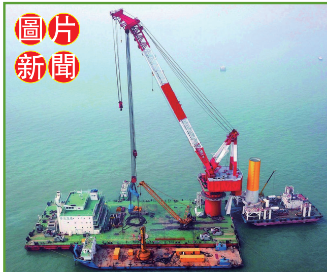
↑江蘇華威啓東海上風電場項目H1標、H2標日前完成首樁沉樁作業，標誌著中國國內單體容量最大的海上風電項目主體工程開工建設。該項目位於啓東市近海海域，工程總裝機容量超過800兆瓦。項目建成後，預計年上網電量達22億千瓦時，每年可節約標煤73萬噸。
